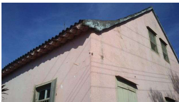
Aspecto volumétrico da edificação.
