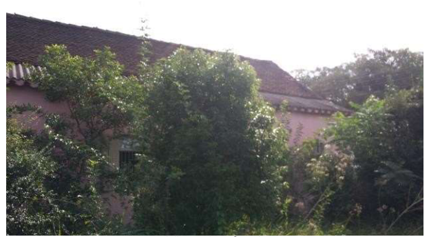
Vista dos fundos.
