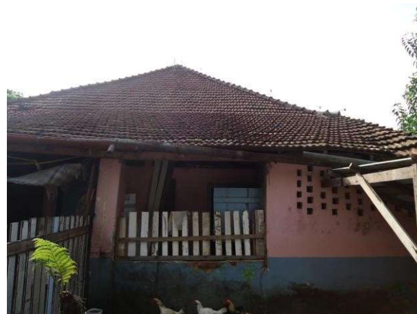
Vista da fachada lateral posterior.
