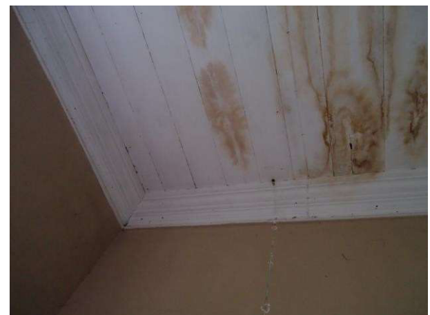
Trecho com forro e rodaforno original.
