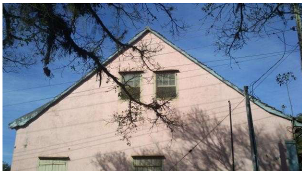
Janelas do sótão.
