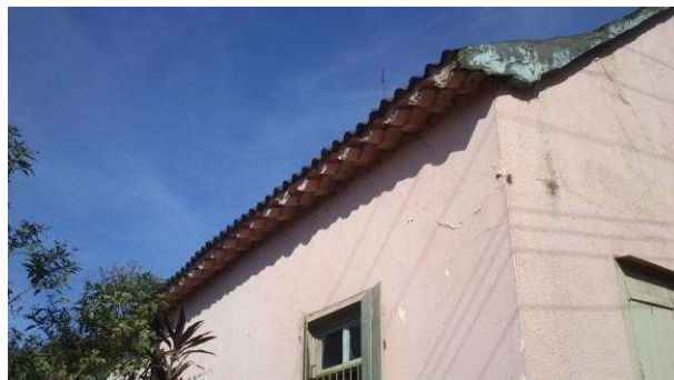
Beiral, sobre o qual dispunham-se as telhas capa-e-canal.
