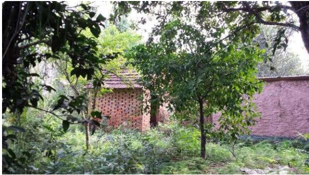
Vista da edificação do galinheiro.
