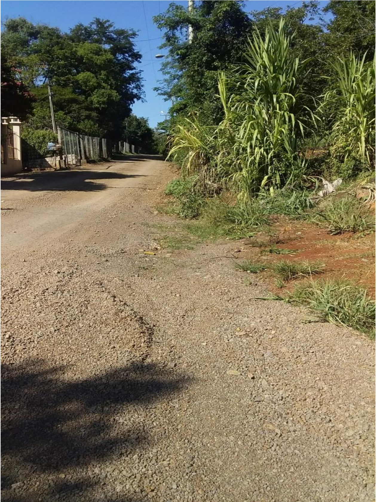
Melhoria nas valetas com aprofundamento e construção de boca de lobo.
