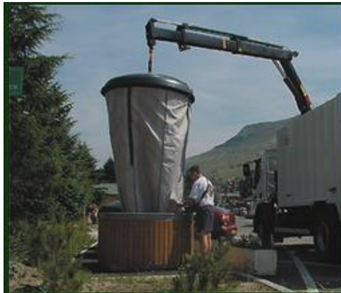
Figura 22: Recolhimento dos resíduos.
