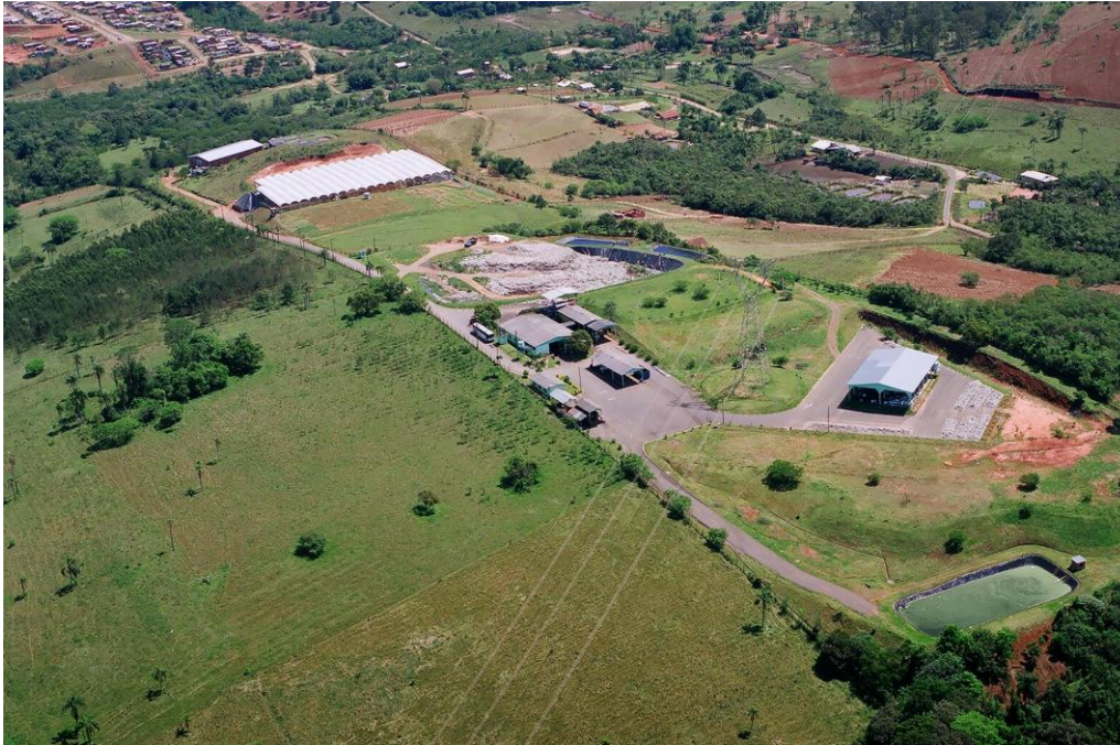
Figura 2 : Vista área da Central Municipal de Resíduos Domésticos de Campo Bom.
